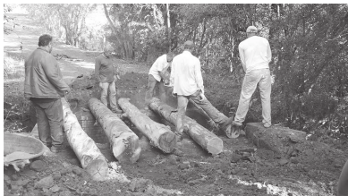
Secretário Osmarino de Brito acompanhando obras da ponte na água do Queixada
