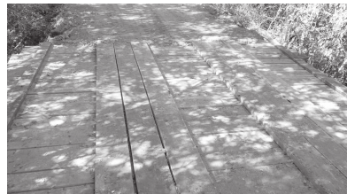
Ponte foi totalmente reconstruída para dar mais segurança aos usuários
