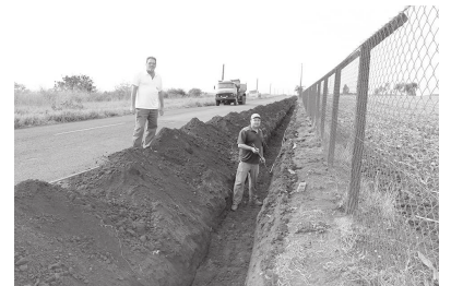
Funcionários do Saae durante execução da nova rede de água no jardim das Flores em CM
