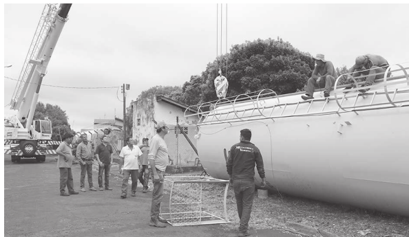
Secretário Angelo Maia e funcionários do Saae durante instalação do reservatório no jardim Betânia
