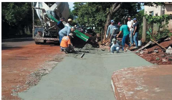
Funcionários da prefeitura executam serviço na região central da cidade
