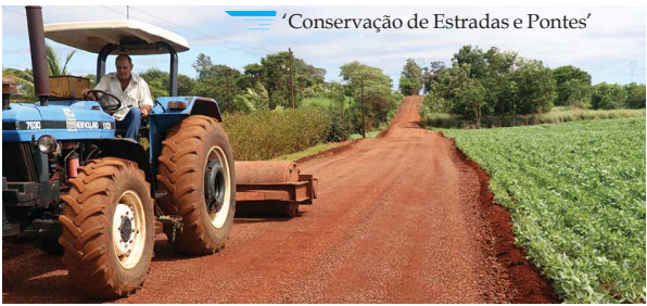
A Secretaria Municipal de Obras de Cândido Mota, através do setor de 'Conservação de Estradas e Pontes', está realizando serviço de empedramento e construção de canteleões para contenção de águas pluviiais. CIDADE Página 3
