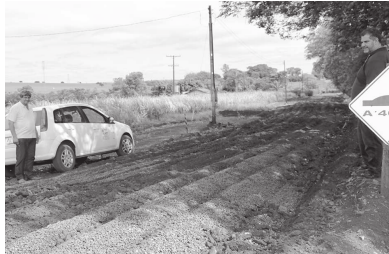
Secretário Osmarino Ferreira acompanhou serviço na estrada rural da água do Queixada
