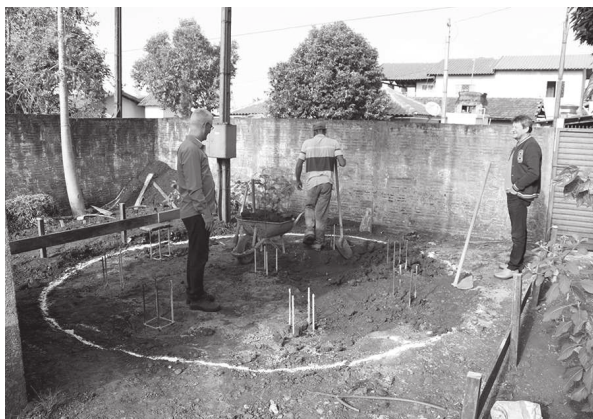
Secretário Ângelo Maia acompanha obras em Porto Almeida ao lado de funcionários do Saae
