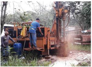
Serviço Autô-nomo de Água e Esgoto, o Saae, está realizando, através de recur-so próprio, a perfuração de um novo poço profundo na subestação 'Paraíso'. A obra visa garantir o aumento na captação de água, que atualmen-te é de 220 mil litros hora, para 300 mil. Segundo o secretário do Saae, Ângelo Maia, a au-tarquia está trabalhando para dar mais segurança ainda à população no abastecimento de água e evitar que ela falte num eventual período de seca CIDADE Página 3
